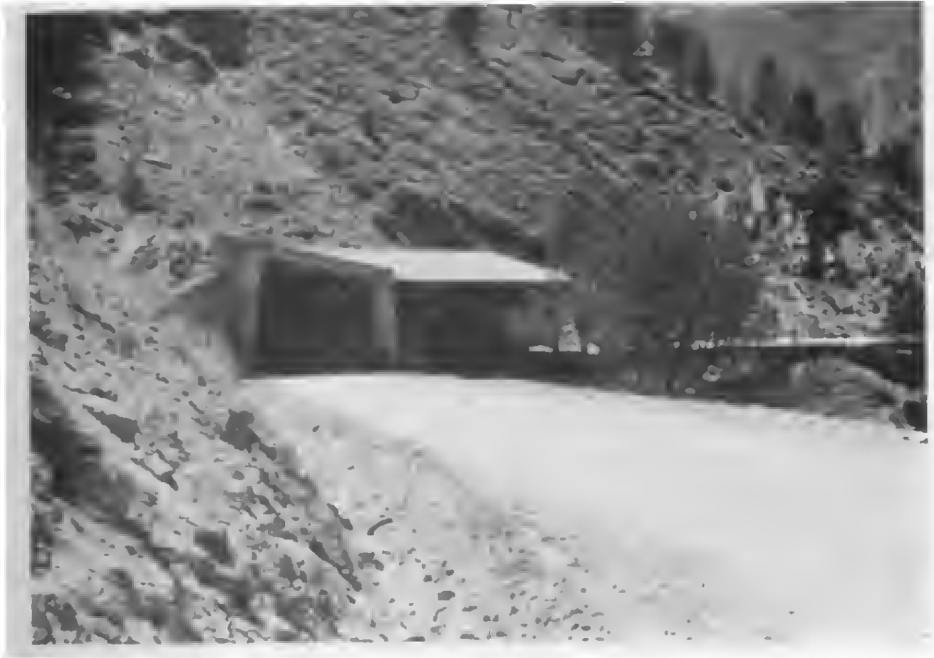
FIG. 15. — Tunnel anti-neige à Zigana.
